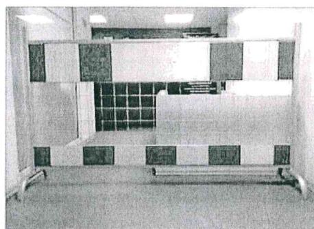
При производстве аварийных работ ограждение зоны производства работ должно иметь сигнальный бело-красный или красно-желтый цвет.
