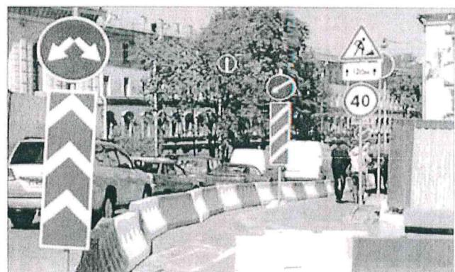
Ограждения выполняются из дорожных блоков (водоотливные ограждения) и предназначены для временного визуального ограждения территории, на которой проводятся ремонтные или строительные работы. Ограждения из дорожных блоков могут быть дополнительно оборудованы световозвращателями и сигнальными фонарями.
